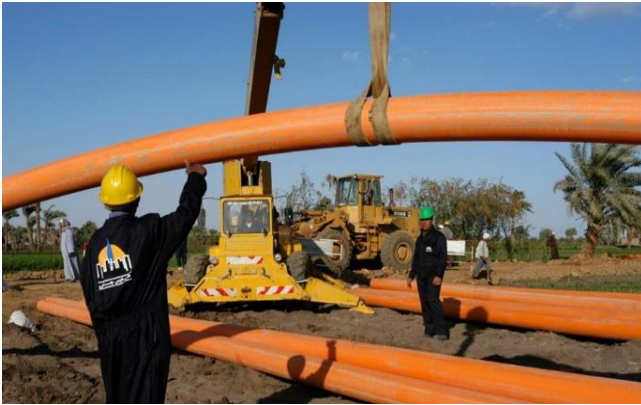
أعمال تركيب أنابيب الغاز الطبيعي
